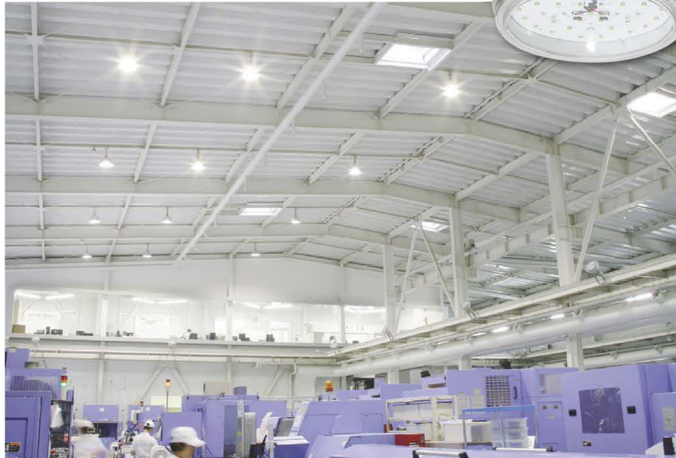
鋼屋パイテック会社様(岐阜県)
