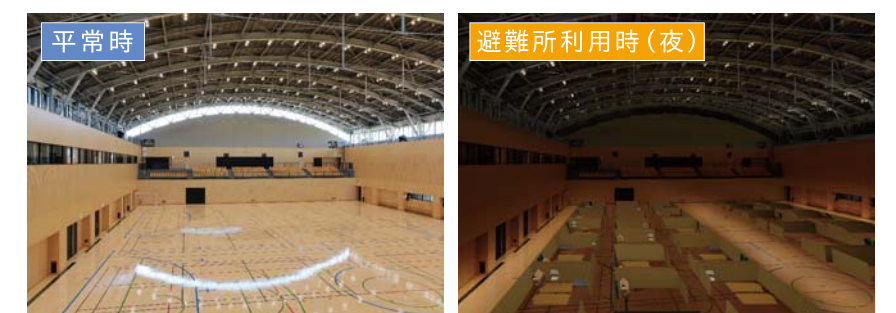
5000K スポーツ利用時はボールや相手がかっきりと見える、明るい昼白色の光に。 2700K 通路は最低限の明るさを確保し、暖色の光で避難者の睡眠を妨げない環境に。
