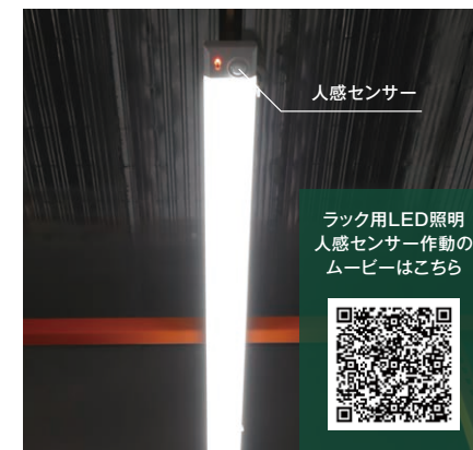
照明器具と一体化した人感センサー。1台ごと付いているので人が立ち入った場所だけ点灯します。
