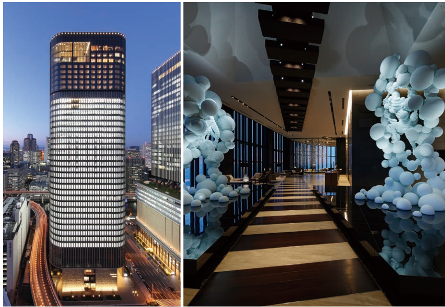
高さ約200m40階建ての 中之島フェスティバルタワー・ウエスト 様
