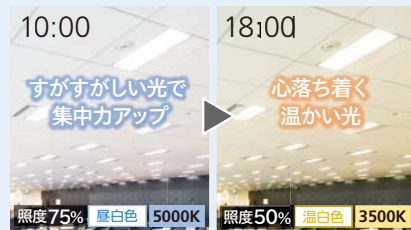
無線照明制御「ライコネックス」の自動スケジュール機能で 時間帯に合わせて照明の明るさ・光色をコントロール。
