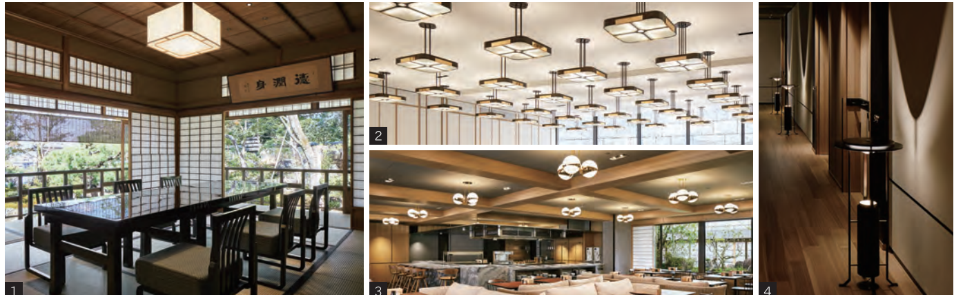
1.同じ敷地内にある昭和24年開業の老舗料亭「山荘 京大和」。客室照明の意匠はそのままにLED化。 2.パーティ会場の照明。下面カバーに薄くスライスした天然の大理石を使用し ている。 3.カジュアルなイメージを取り入れたカフェダイニングの照明。 4.廊下やリビングルームなど随所に設置された統一感のある行灯風照明。
