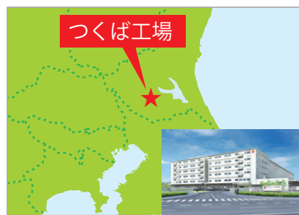
つくば工場 (2018年1月竣工予定) 国内2拠点目となるLED照明の生産工場建設により、関東圏へのLED照明の供給を強化します。
