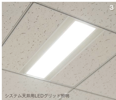
2. 関西最大規模の無柱オフィス空間。照明は光源ユニットが交換でき、フレキシブルなスペース活用を助けます。 3. 発光効率136lm/Wの高い省エネ性能を実現。輝度ムラを抑えた自然な明かりで快適性を向上します。
