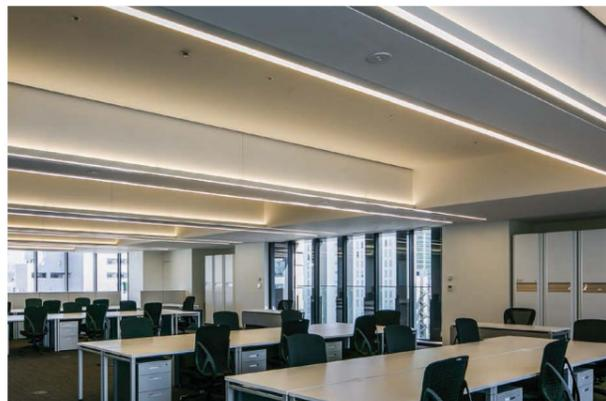
フィオリートビルは、働く社員のことを考え、知的業務の生産性が向上する環境が整えられています。室内には、建築物と一体化した特別開発のLED照明を設置。薄型のLED照明器具がひろびろとした天井空間を実現しました。また、照明を自在に調整する調光システムによって、空間の用途や時間帯に最適な照明環境を作り出しています。
